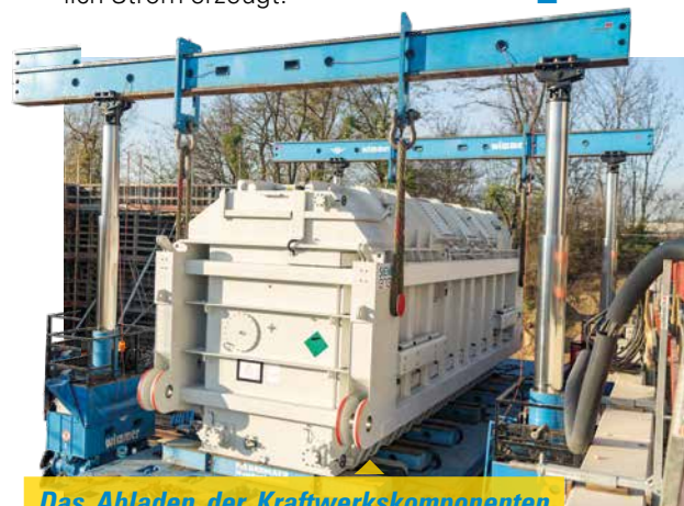
Das Abladen der Kraftwerkskomponenten wurde mittels Hubgerüst bewerkstelligt.
