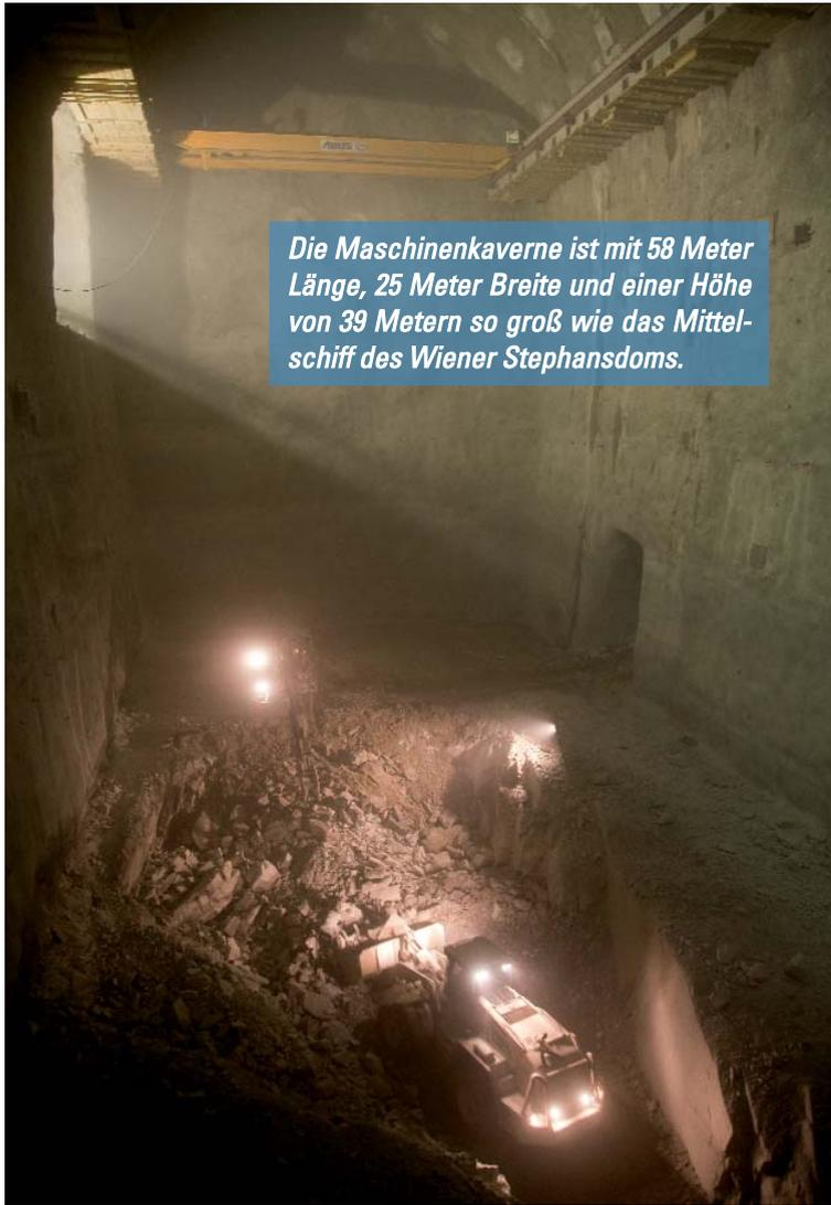
Die Maschinenkaverne ist mit 58 Meter Länge, 25 Meter Breite und einer Höhe von 39 Metern so groß wie das Mittelschiff des Wiener Stephansdoms.
