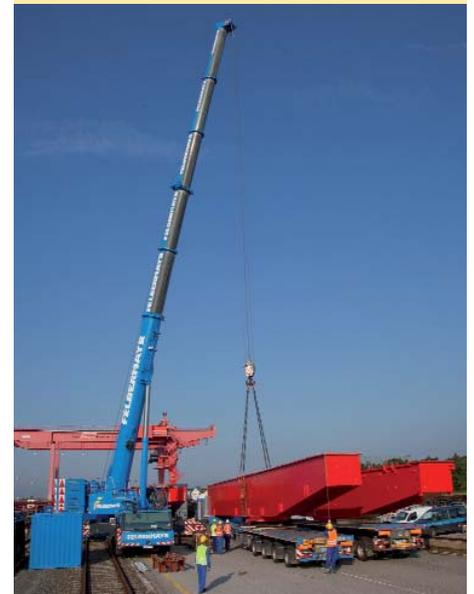
Für die Errichtung eines weiteren Portalkrans am Container-Terminal Wels führte Felbermayr von Juli bis Ende August etwa zwanzig Transporte durch. Auch für die Montage der bis zu 25 Tonnen schweren Elemente kam Felbermayr zum Einsatz – ein Mobilkran mit 350 Tonnen Traglast unterstützte die Monteure dabei.
