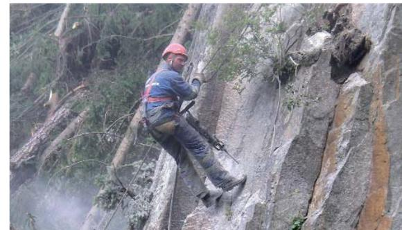
Insgesamt wurden 10.000 Laufmeter Anker verbaut.
